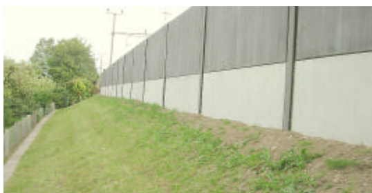
Lärmschutzwand aus Beton (Anwohnerseite)
