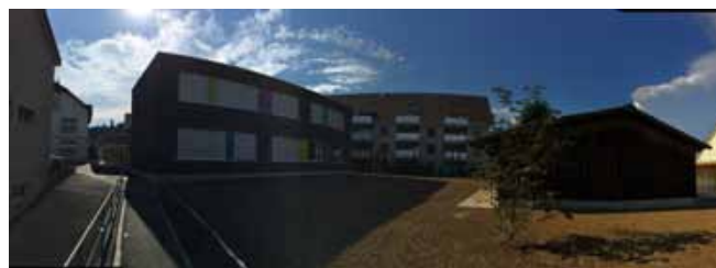
Ostfassade mit neuer Umgebung
