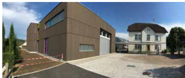
Nord- und Westfassade mit gepflastertem Platz
