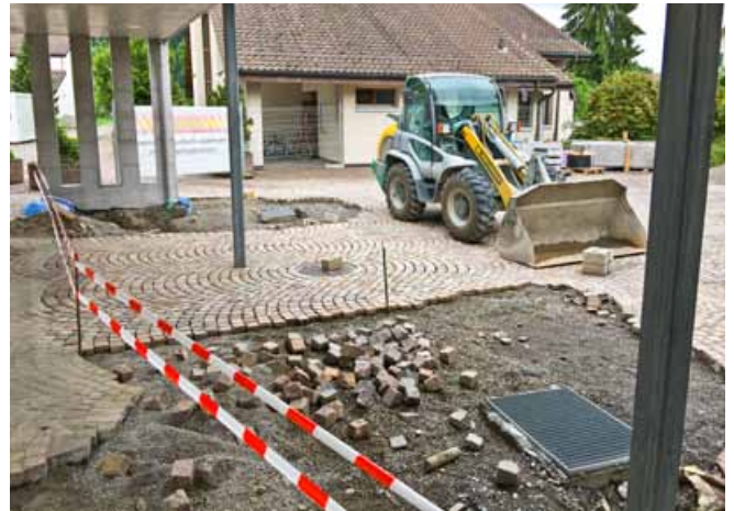
Erneuerung der Steinpflästerung
