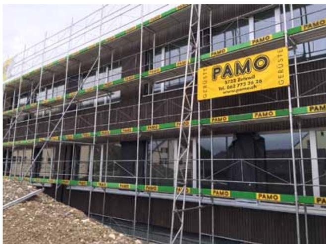
Holzfassade hinterlüftet (Ostseite), farblich vorvergraut mit Vertikalstruktur
