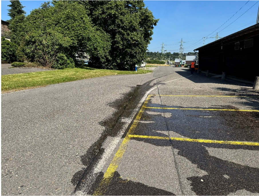
Industriestrasse Bereich Lagerhalle aus Holz (Foto Richtung Nord-West)
