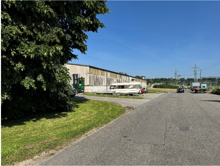
Industriestrasse Bereich Kistenfabrik Jimmy GmbH (Foto Richtung Nord-West)
