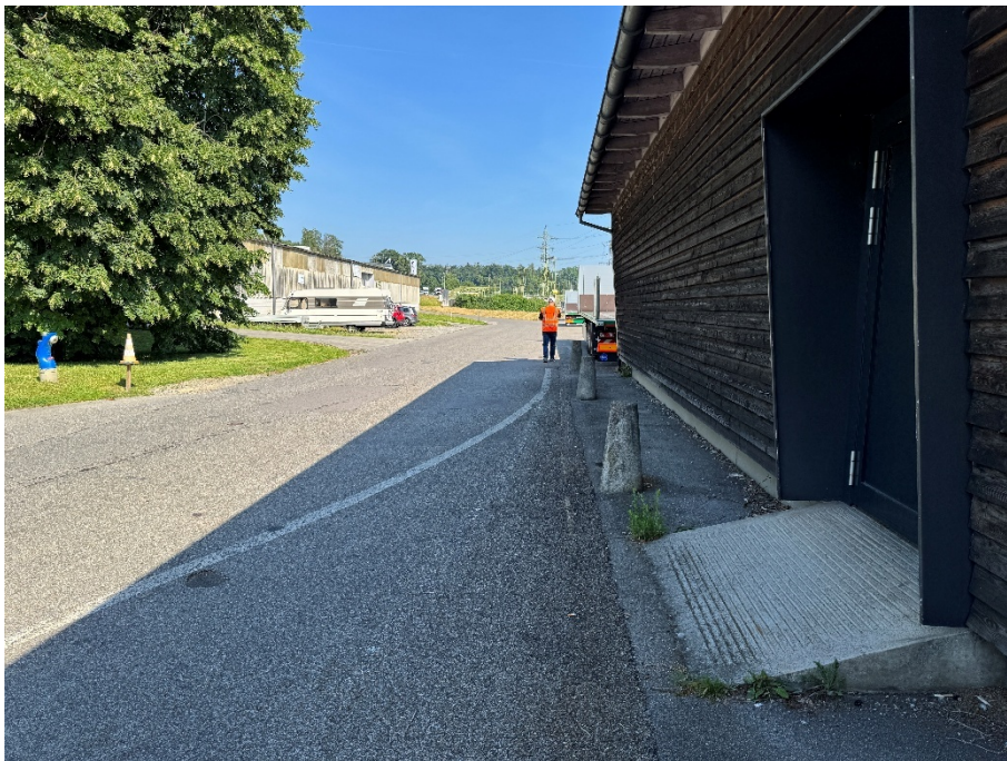
Industriestrasse Bereich Hydrant (Foto Richtung Nord-West)
