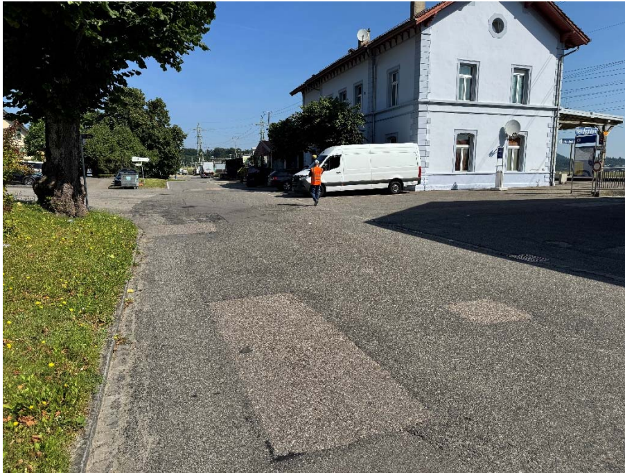
Industriestrasse Bereich Einmündung Bylandweg (Foto Richtung Nord-West)
