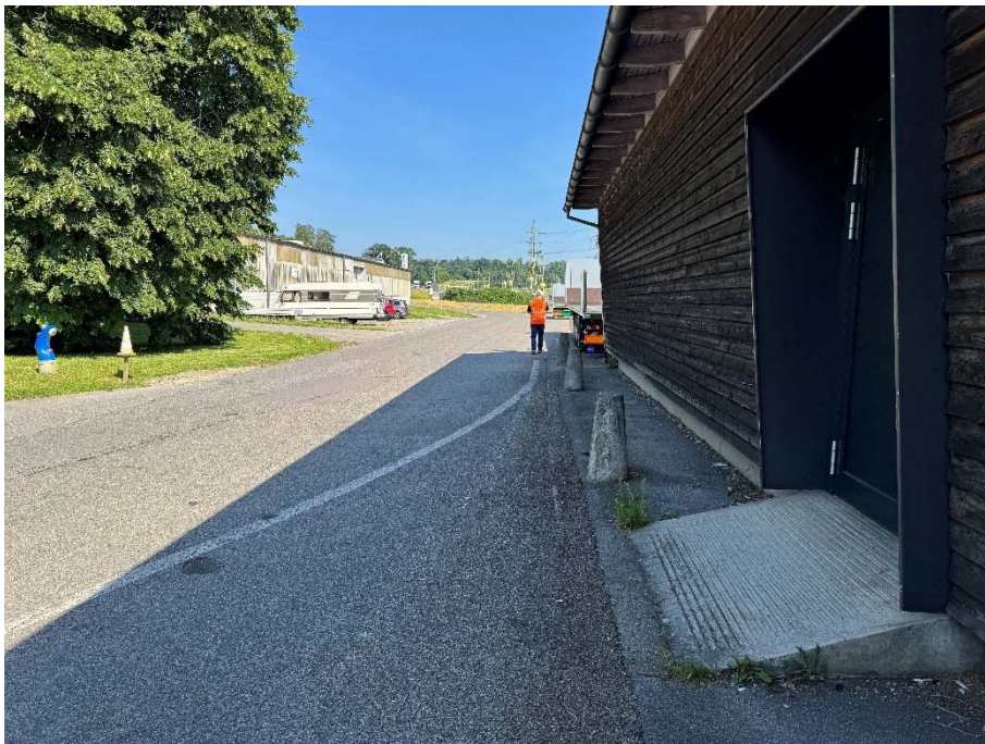
Industriestrasse Bereich Hydrant (Foto Richtung Nord-West)
