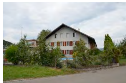
Abb. 44: Neu aus kommunalem Substanzschutz entlassen: Wohnhaus, Fassade HEK916
