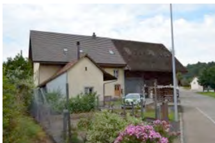
Abb. 43: Neu aus kommunalem Substanzschutz entlassen: bäuerlicher Vielzweckbau HEK915
