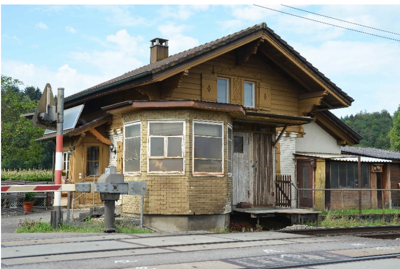
Gleisseitige Ansicht von Norden (2020)
