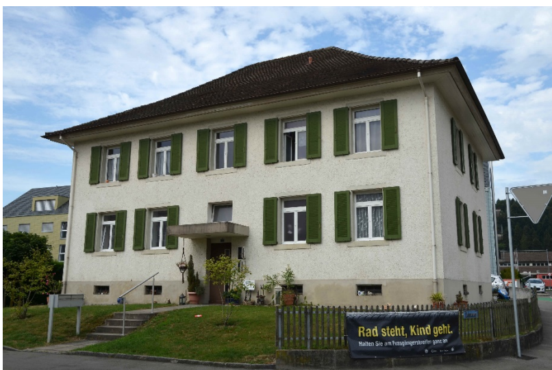
Strassenseitige Ansicht von Osten (2020)
