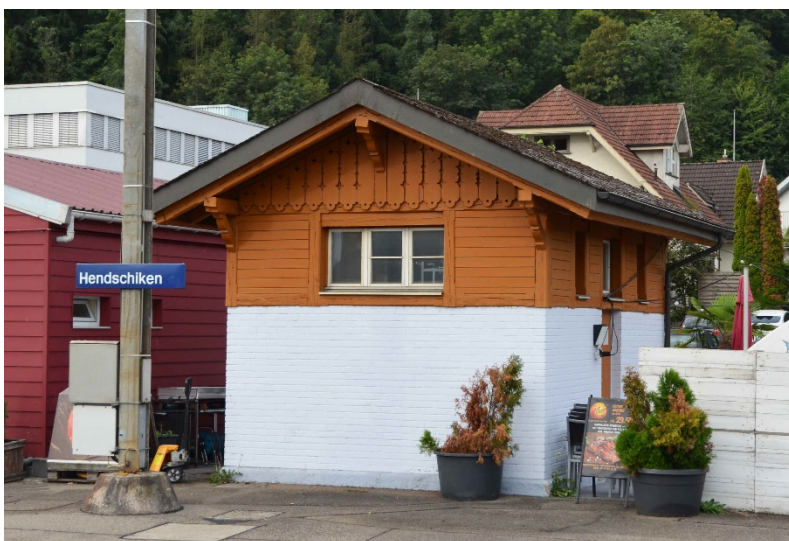
Gleisseitige Ansicht von Südwesten (2020)
