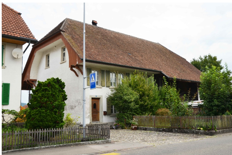
Ansicht strassenseitige Hauptfassade von Süden (2020)
