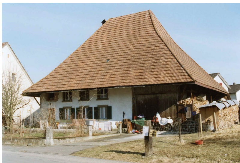
Strassenseitige Ansicht von Westen (Kurzinventar 1999)
